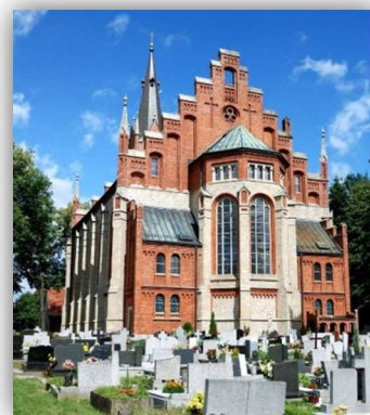
Zespół zabudowy kościoła parafialnego pw. św. Apostołów Piotra i Pawła w Woszczycach
